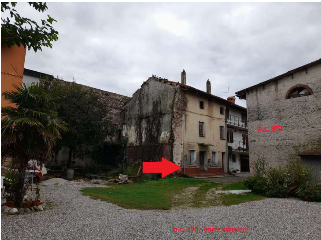
p.c. 390 corte comune e fabbricato su p.c. 395 e fabbricato su p.c. 872 e altri fabbricati
