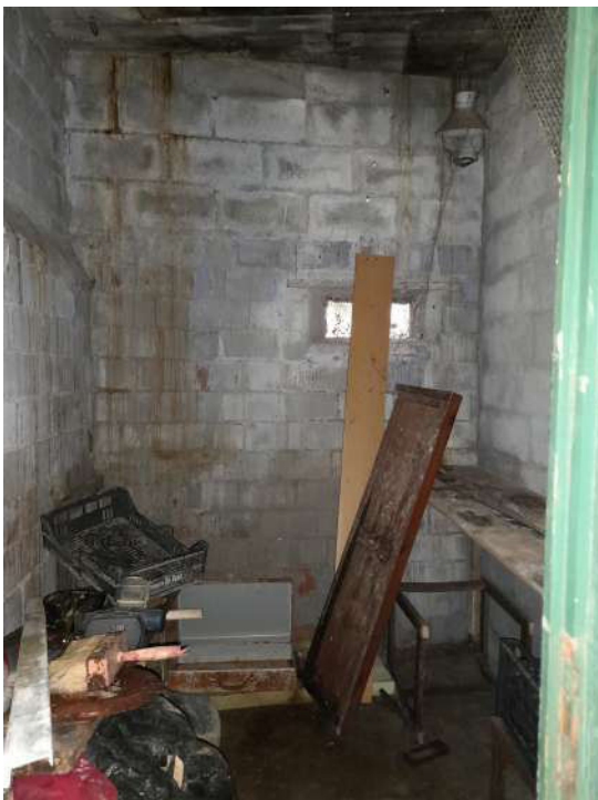
ripostiglio interno al piano terra
