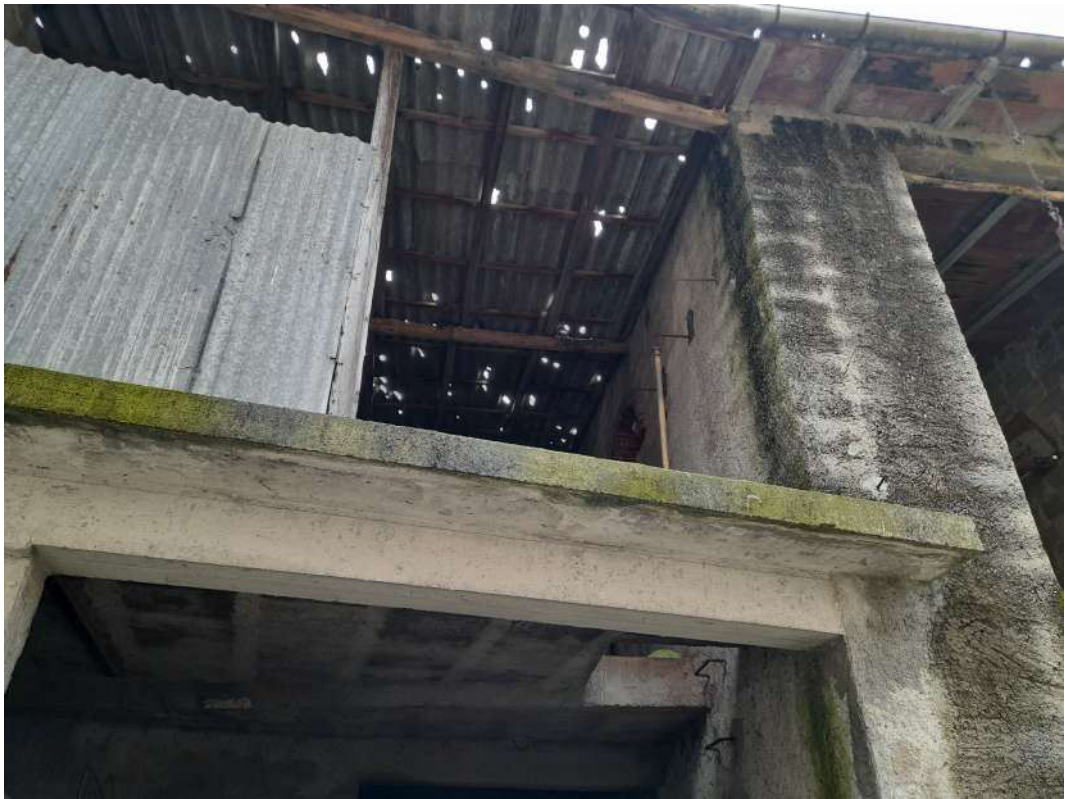
particolare della copertura forata
