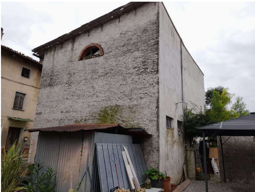
facciate laterale e posteriore
