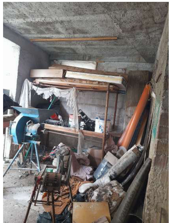
deposito al piano terra
