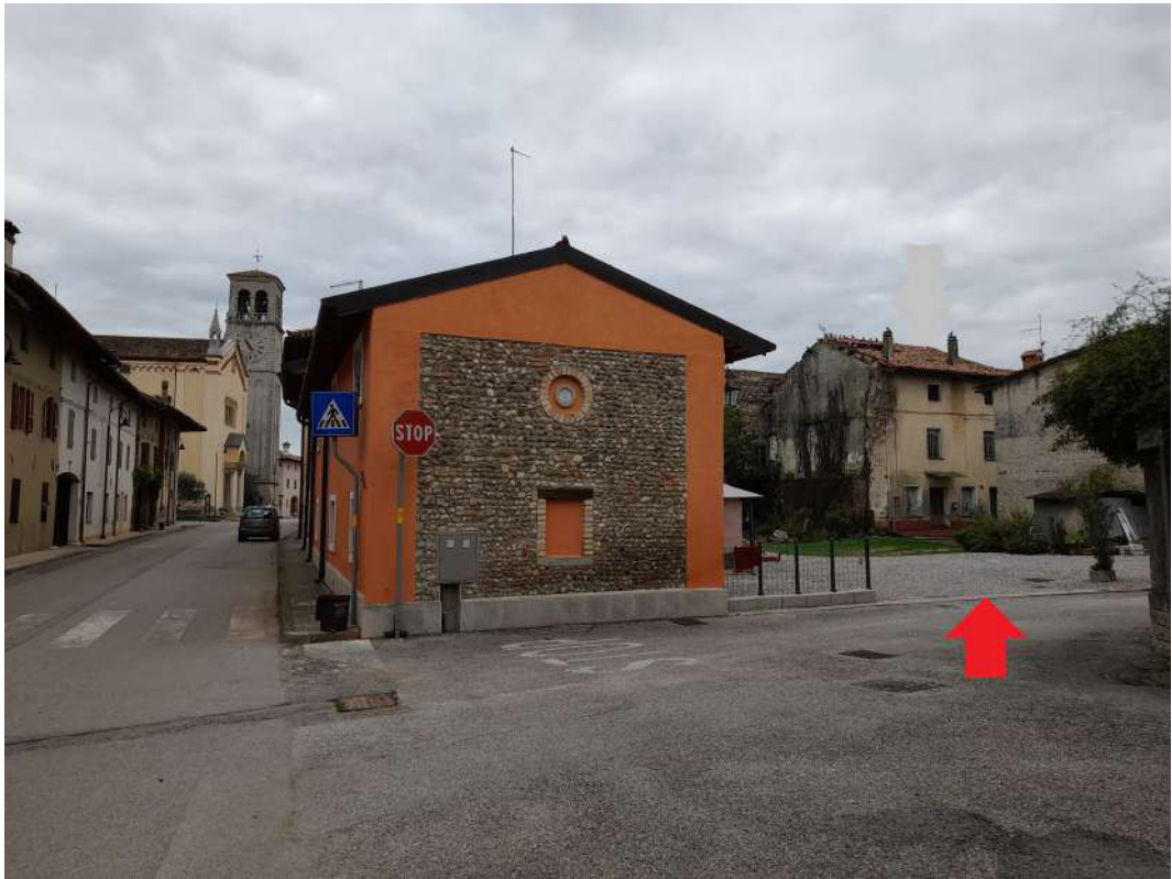
Incrocio tra vicolo Consorti e via Sant'Andrea ed accesso al fabbricato
